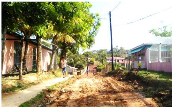
El proyecto contempla la excavación de tierra, compactación y revestimiento con material selecto en sectores de difícil acceso a la falta de calles de concreto, obra que ayudará a mejorar las condiciones de acceso a las familias.
